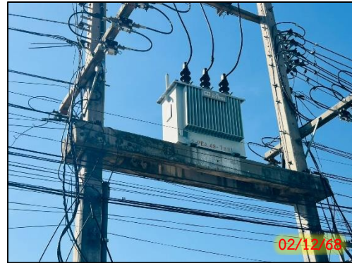
รูปที่ 2.2-12 หม้อแปลงภายในโครงการ
